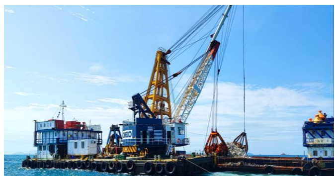
在已完成沖噴的管道上鋪上石塊保護層
