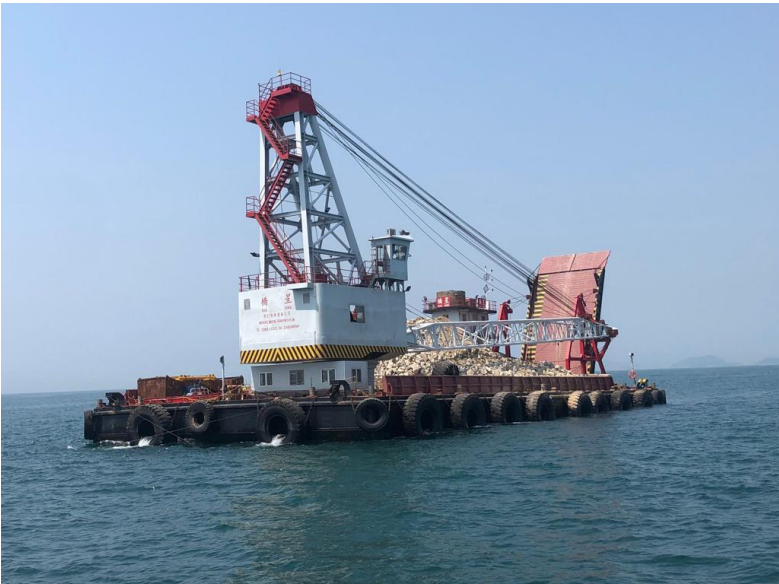
在已完成沖噴的管道上鋪上石塊保護層
