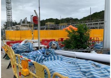
使用不透水的帆布覆蓋臨時儲存物料
