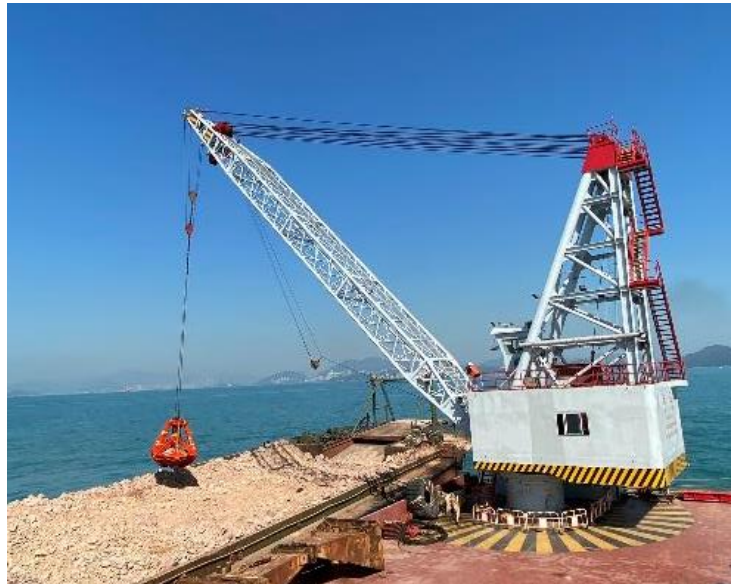
在已完成沖噴的管道上鋪上石塊保護層
