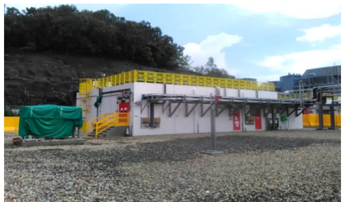
天然氣接收站工地
